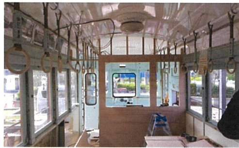
内装工事の様子
